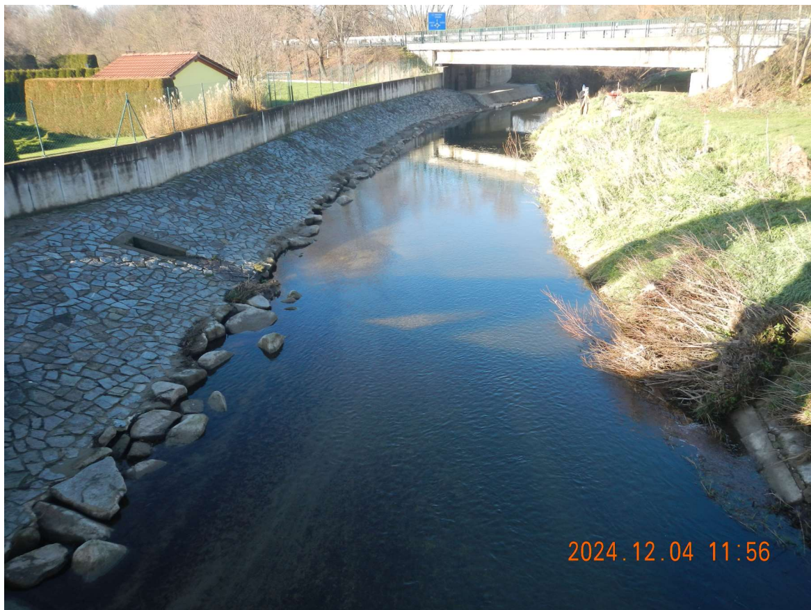
Poškozená levá patka koryta Novohradky v úseku mezi mosty
