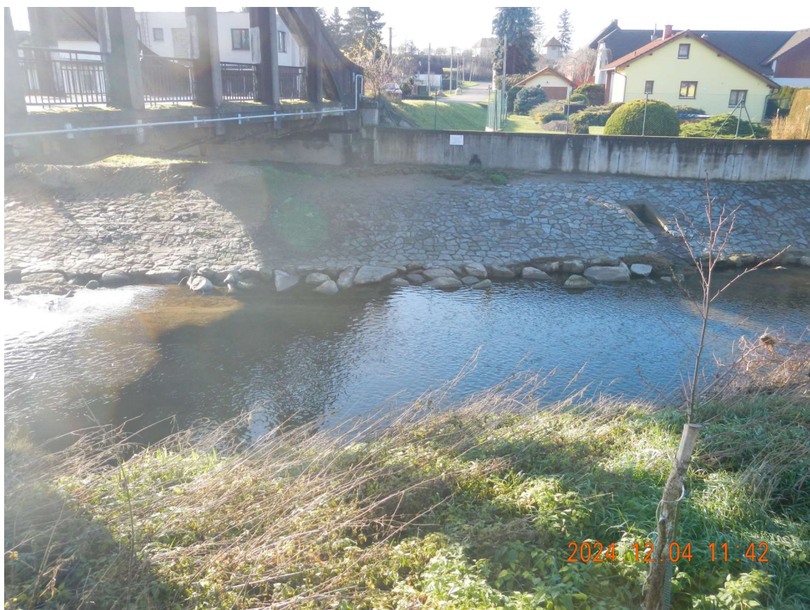
Poškozená levá patka koryta Novohradky u starého mostu
