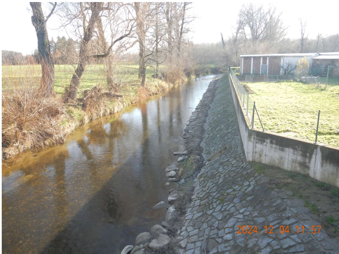
Poškozená levá patka koryta Novohradky před starým mostem (pohled proti proudu)
